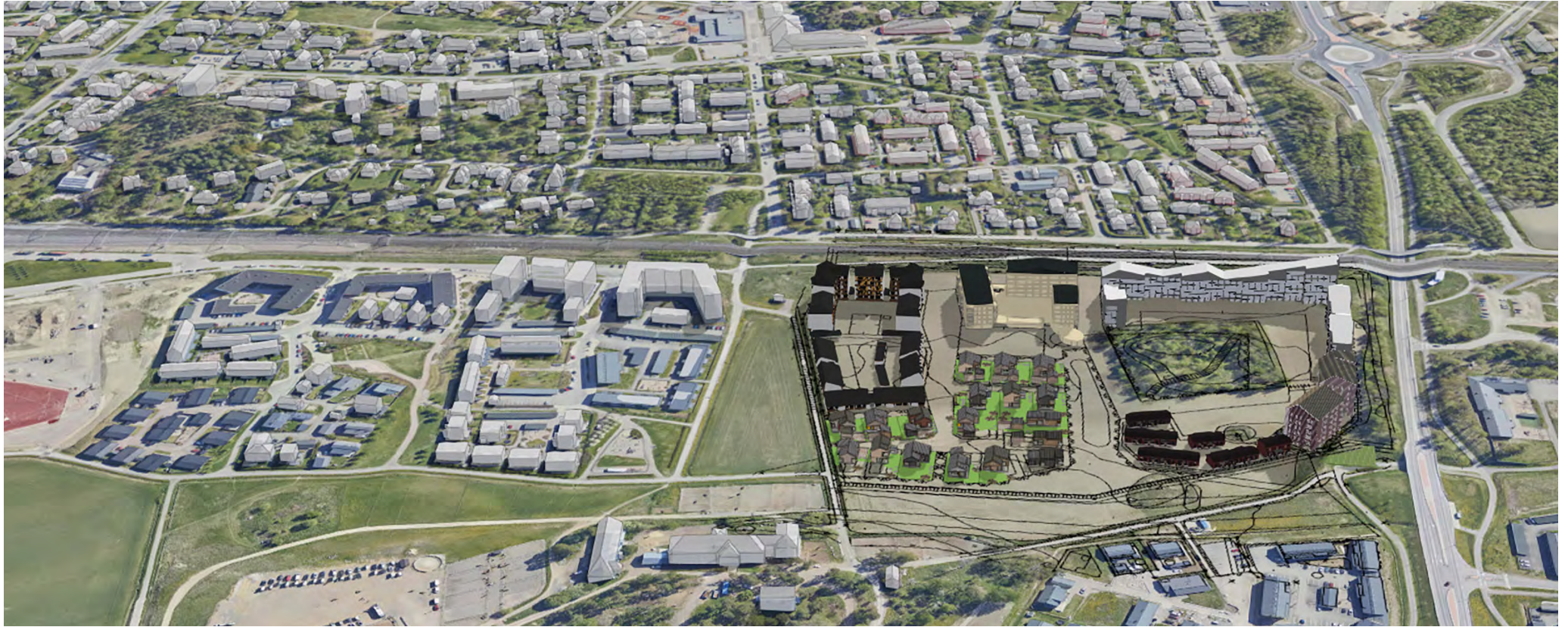
Lepola IV alue sijoittuu rakennettujen asuinkortteleiden ja Ainolanväylän väliin. Yläkuvassa yleisnäkymä lännestä. Alakuvassa Ainolanväylän varren uutta julkisivua, taustalla tiivistyvää keskustaa ja Kyrölään asuntoalueita.
